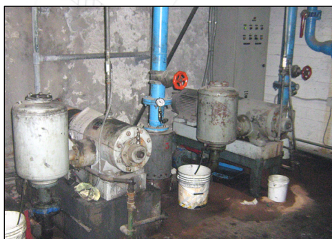
Dos bombas V45 enfriadas por agua de 1963
