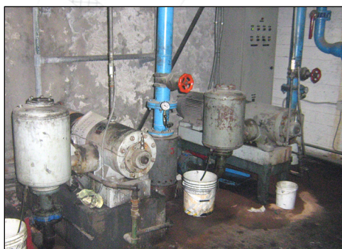
Due pompe V45, del 1963, raffreddate ad acqua
