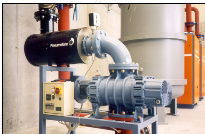
Bombas "roots" Pneumofore de segundo estadio, detalle instalación cliente
