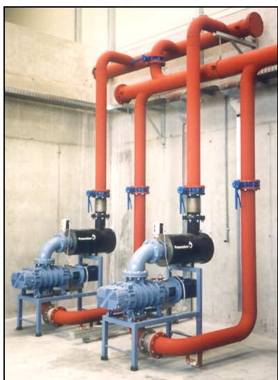
Bombas "roots" Pneumofore de segundo estadio
