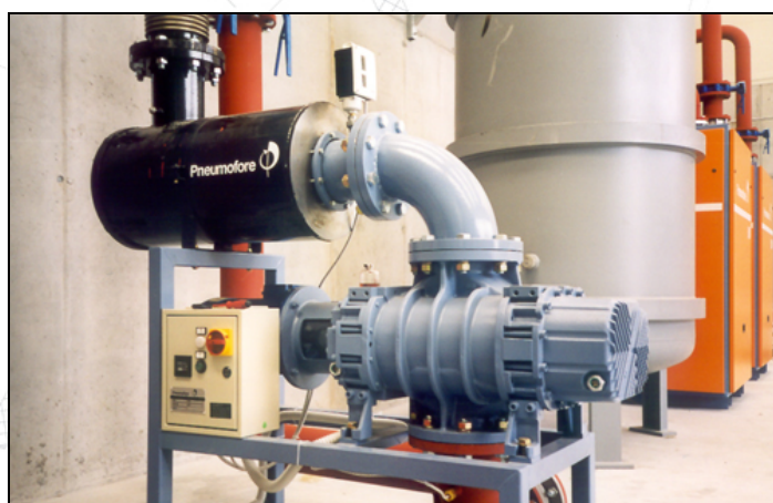
Насос Рутса, установка на заводе
