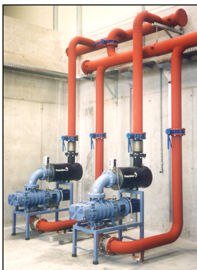
Насос Рутса в качестве второй ступени
