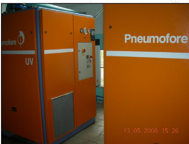
Bild 3 - Zwei UV16 Vakuumpumpen
