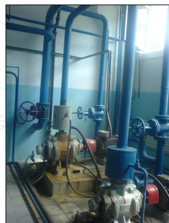
Fig. 2 - Pompe ad anello liquido
