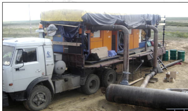
Camión estación de gasolina y bombas UV
