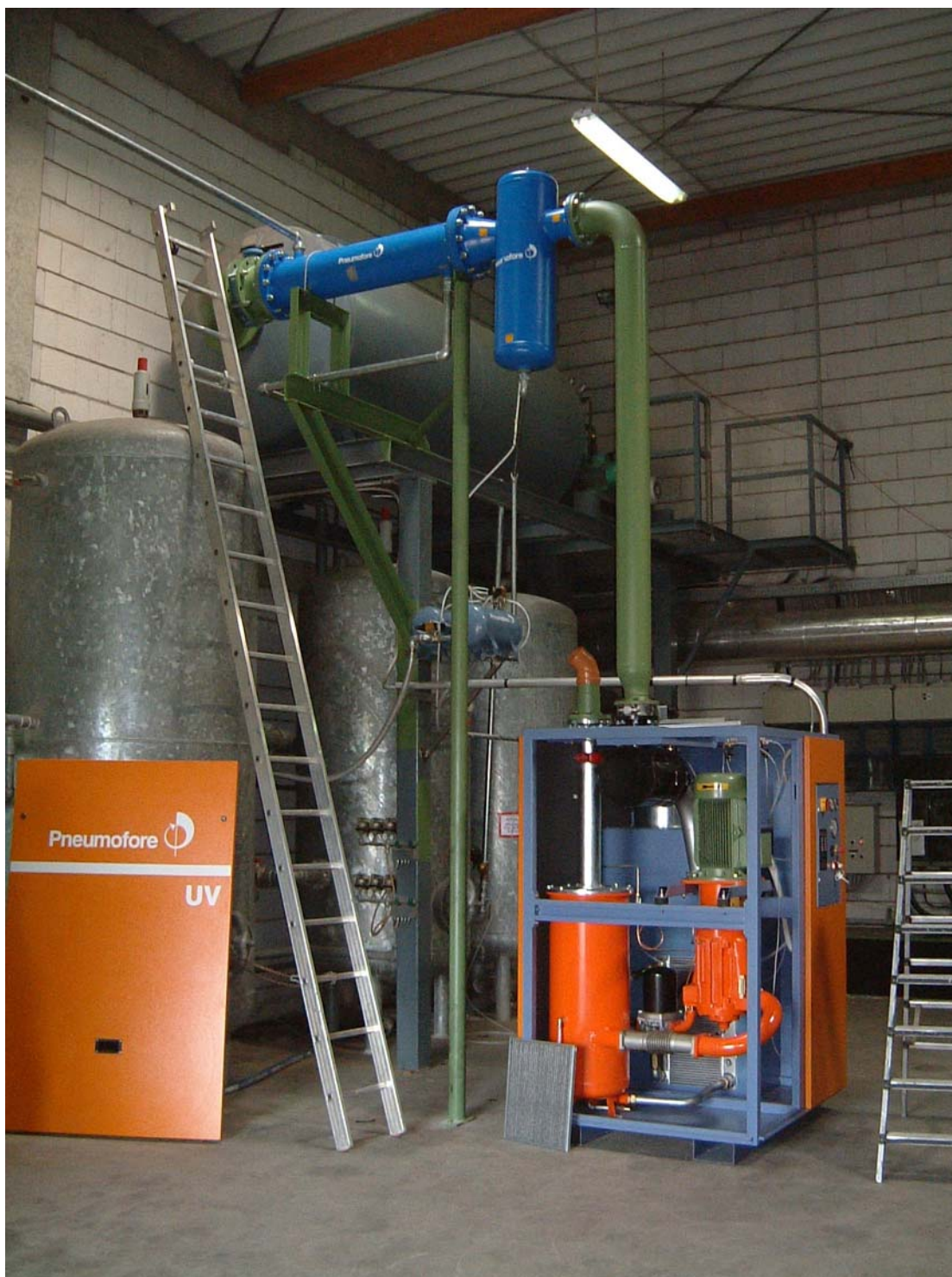
Installation Pneumofore Vakuumpumpe und zusätzlicher wassergekühlter Kondensator
