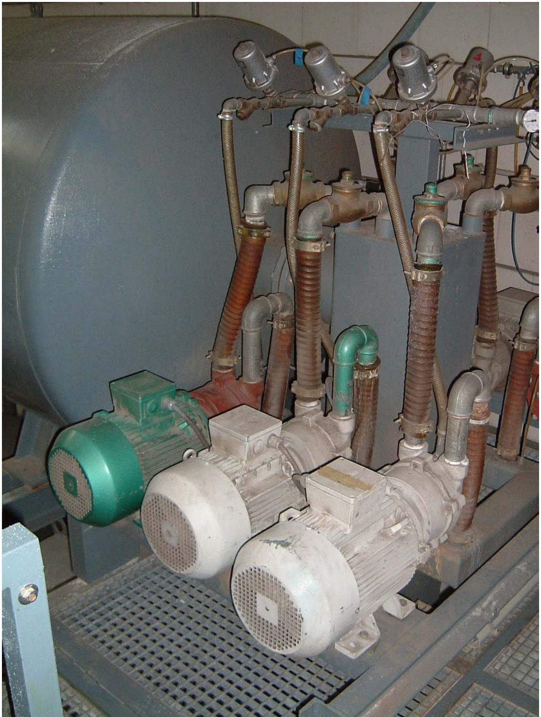
Anschlüsse Wasserringpumpen Vakuumbehälter
