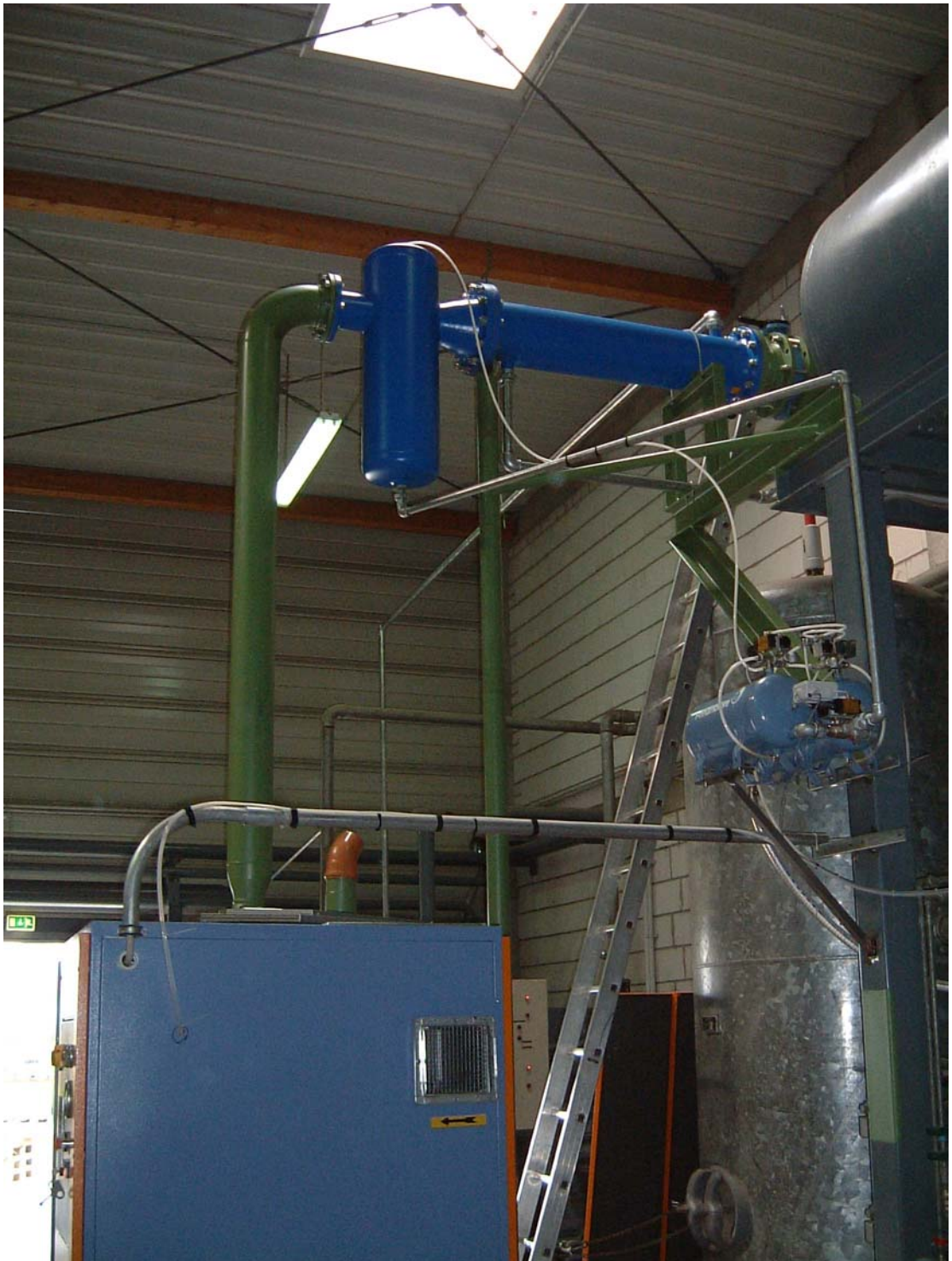
Installation des wassergekühlten Kondensator und Kondensat-Ablassbehälter
