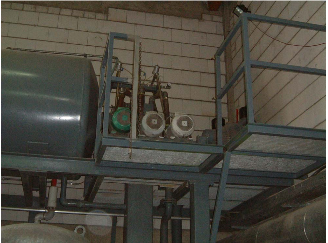
Wasserringpumpen und Ausgleichbehälter
