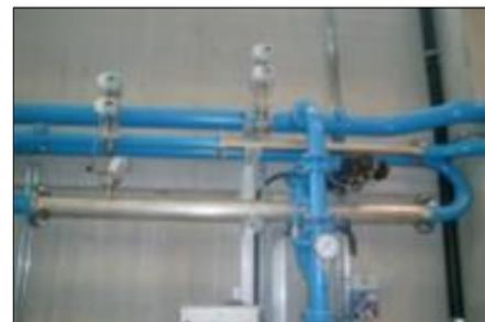
*2 tubi di misurazione (acciaio inox) DN80 e DN150 con 2 PoetterSensors® e 2 trasduttori DP per ciascun tubo.*
