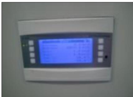
*I nostri computer per la misurazione del flusso d'aria C 621, basati sui metodi migliorati di calcolo della pressione differenziale, in accordo alle norme EN ISO 5167, che mostrano costantemente la misurazione precisa dei 2 tubi con 4 trasmettitori DP in split-range.*
