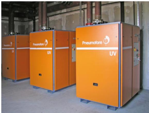
**Bild 3** - Drehschieber-Vakuumpumpen mod. UV16
