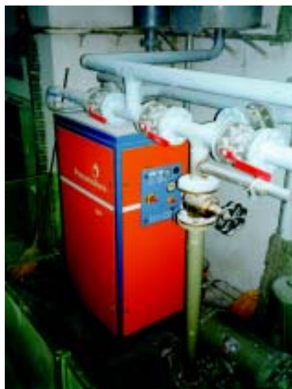
Fig. 2 - Pompa a vuoto Pneumofore tipo UV16 presso Italtasta - La Loggia (TO)
