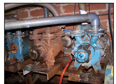
Photo 4 - Détail des pompes remplacées
