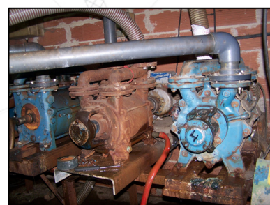
Foto 4 - Dettaglio delle pompe sostituite
