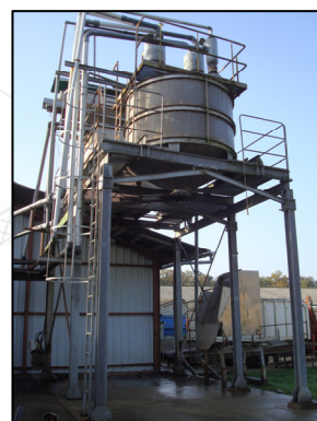
Foto 1 - Torre di separazione
