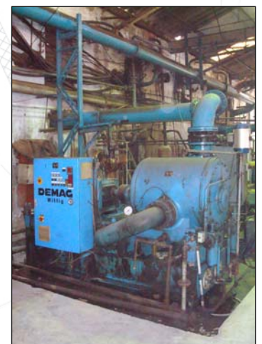
Diese Wittig WPSO Pumpen wurden ersetzt
