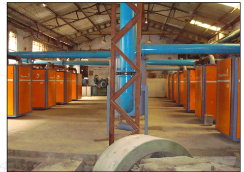
Salle pompes avec 10 x UV50 VS90 HC
