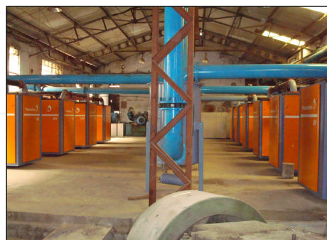
Sala pompe con 10 x UV50 VS90 HC
