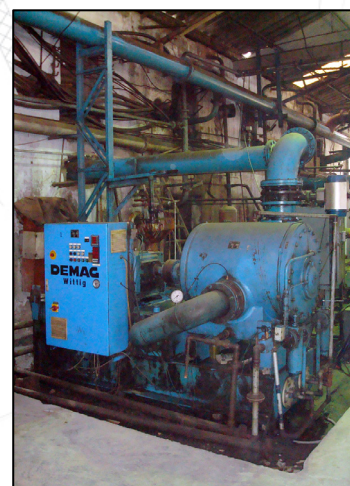
Pompe Wittig WPSO sostituite
