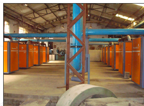
Машинный зал с 10 насосами модели UV50 VS90 HC
