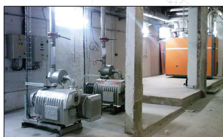
Sinistra: le pompe obsolete; destra: la UV30 VS55
