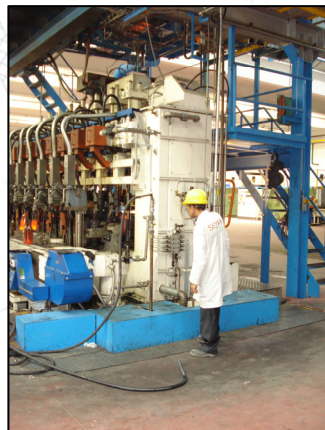
Установка новой стеклоформирующей машины Emhart
