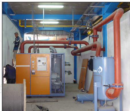
Машинный зал с 2 насосами UV30, 2010 г
