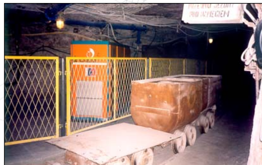
700 m unter der Erde, läuft seit 2002 bei 5,2 bar(g)
