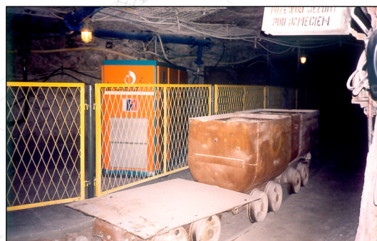
Compresores de aire AS75/V en la mina de sal de Klodawa, 700 m bajo tierra, operando desde 2002 @ 5,2 bar(g)
