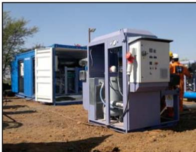
Nach der Entwässerung durch Molche wurde das Vakuumtrocknungsverfahren angewandt. Das beträchtliche Volumen von 102.000 m<sup>3</sup> wurde in nur 6 Tagen auf 0,3 mbar(a) reduziert, was dem Taupunkt von -32° C entspricht.
