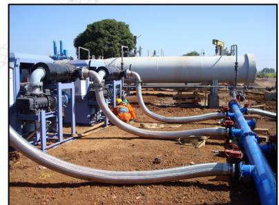
L'asciugatura delle tubazioni avviene immediatamente dopo il processo di pre-asciugatura, che viene eseguito con i "pigs" sospinti tramite aria compressa ad una velocità di 2 km/h [1,25 mph]. Oggigiorno i "pigs" sono in grado di raccogliere anche informazioni sulla geometria interna delle tubazioni, come il diametro costante o la forma ovale, le riduzioni di spessore, etc.
