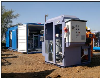
Метод вакуумной осушки трубопроводов был применен после предварительной откачки воды посредством скребков. Всего за 6 дней с помощью вакуума было удалено 102000 куб. м воздуха; при этом значение остаточного давления составляло 0,3 мбар(а) [29,905 in Hg (V)] при точке росы  $-32^{\circ}\text{C}$  [ $-25,6^{\circ}\text{F}$ ].
