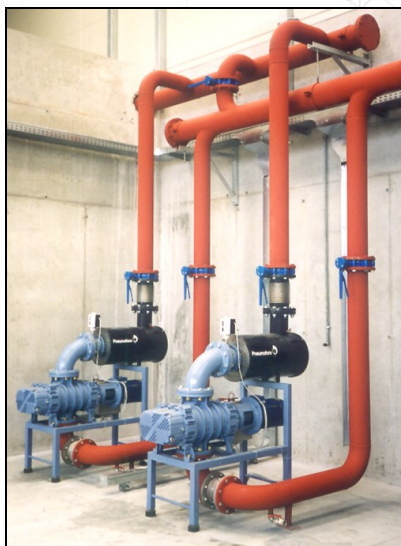
Zweite Stufe, Roots Pumpen
