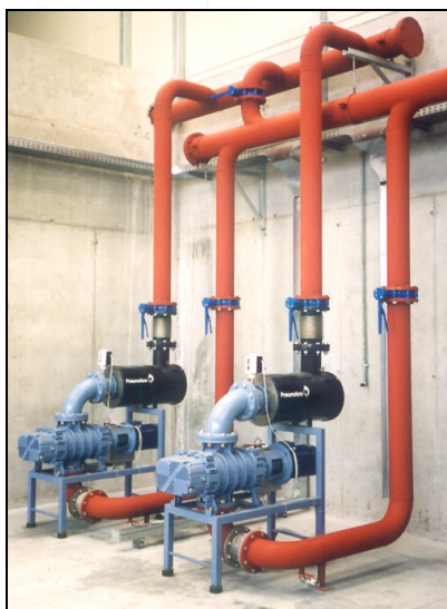
Насос Рутса в качестве второй ступени
