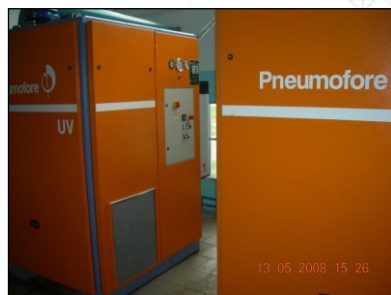
Bild 3 - Zwei UV16 Vakuumpumpen
