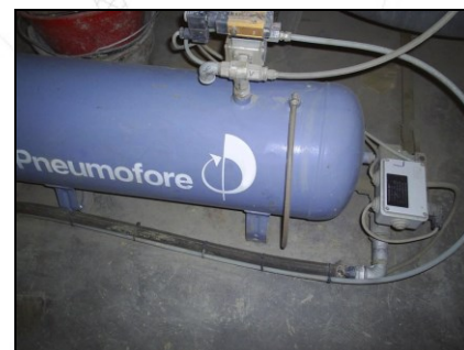
Fig. 4 - Condensate drainer
