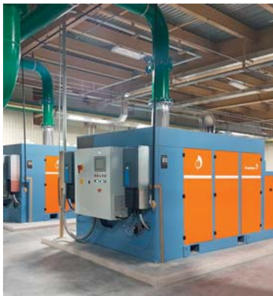
Die zwei UV100-VS180-Vakuumpumpen liefern für die Herstellung von Glasflaschen zusammen 13 000 m³/h.
