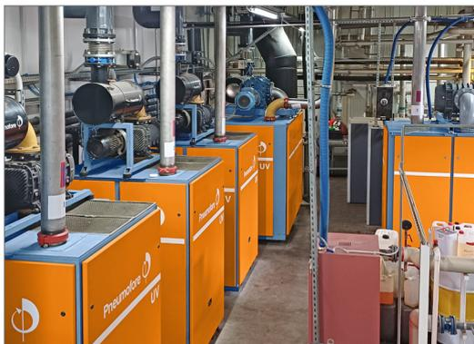
Ante la creciente demanda de un envasado eficiente de embutidos y otros alimentos perecederos, las soluciones de vacío centralizado se han consolidado como el estándar en la industria. Estos sistemas reemplazan configuraciones tradicionales basadas en múltiples bombas de vacío pequeñas, reduciendo significativamente las emisiones de aceite y los niveles de ruido en las instalaciones de producción.
